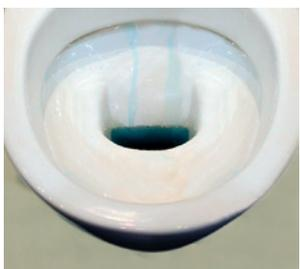
Wasserverlust geht ins Geld: Ein undichter Spülkasten verschwendet bis zu 90 m<sup>3</sup> Wasser, das sind Kosten von ca. 400 Euro pro Jahr.
